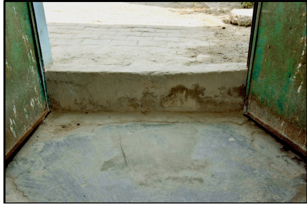
Door of Kulesra AWC No. 2
