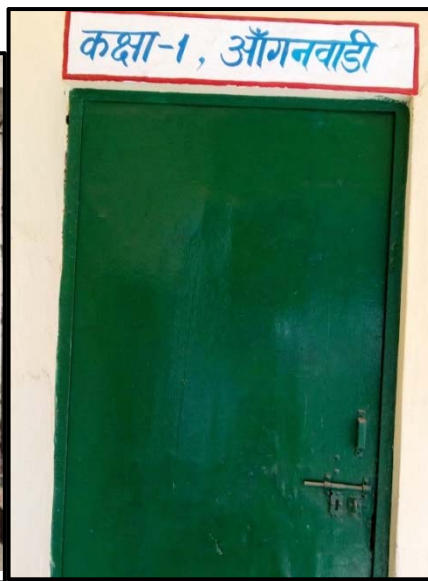
Door of Rozayakubpur AWC 1
